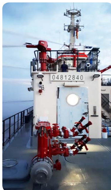
In vollem Einsatz
