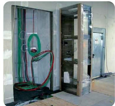
Verlegung der Video-, Kamera-, Modulations- und Steuerungskabel
