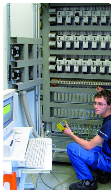
Durchführung einer Isolationsmessung
