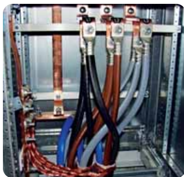
Kabelanschluss SIVACON
