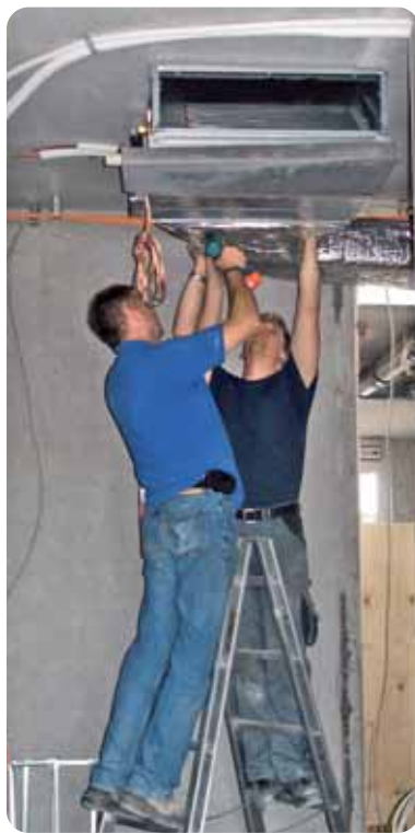
Montage eines Deckenkühlers
