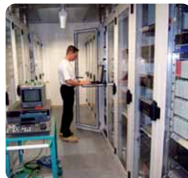
Arbeiten im Serverraum
