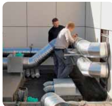
Montage der Zuluflleitung
