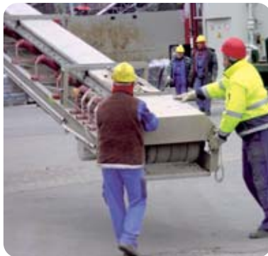
Rückbau des vorhandenen Förderbandes
