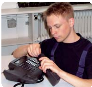
Arbeiten an der Telefonanlage
