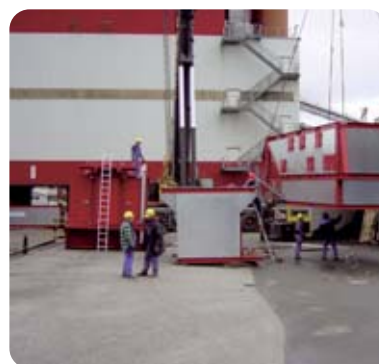
Montage der neuen Baugruppen
