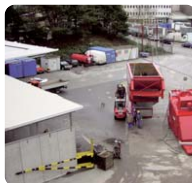
Montage des Rüttelsiebs
