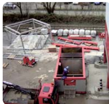
Vorbereitende Arbeiten an Neuteilen
