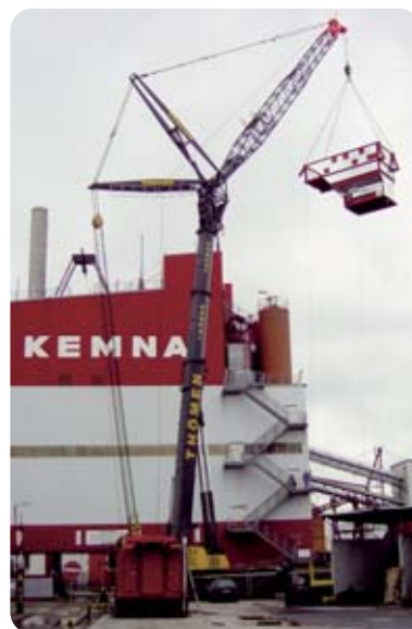
Der 400-t-Kran im Einsatz
