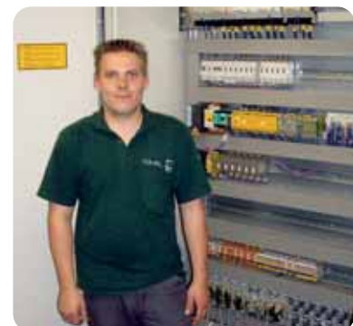
Ole Harnischfeger vor einer Schaltanlage
