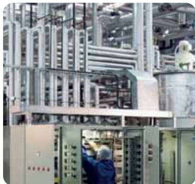
Rohrleitungsbau und Automation bei einem Kunden der Lebensmittelindustrie
