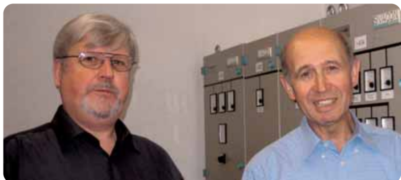
Herr Friedemann (li) und Herr Jaschke von Sealed Air Norderstedt vor der Trafostation 1, der Schaltanlage für Unterverteilungen und Maschinen
